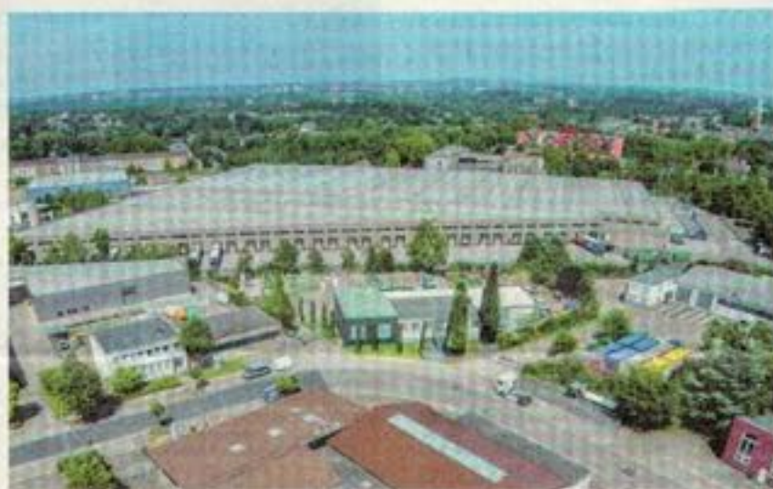
Das Logistikzentrum von Aldi Nord in Kray wird im nächsten Frühjahr abgerissen. Bis 2020 entsteht dort die neue Zentrale des Handels-Riesen.
